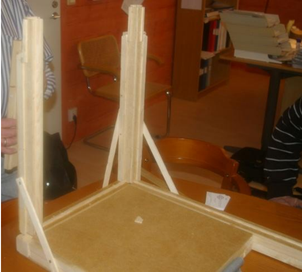
Figur 2. Hörnpelare och mellanpelare monterade
