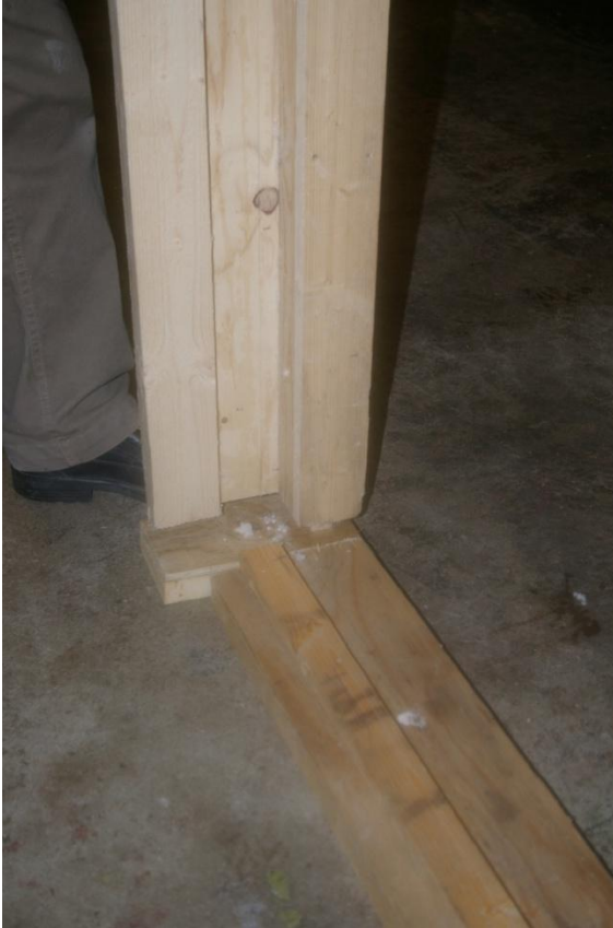
Figur Montering pelare till hörnsyll
