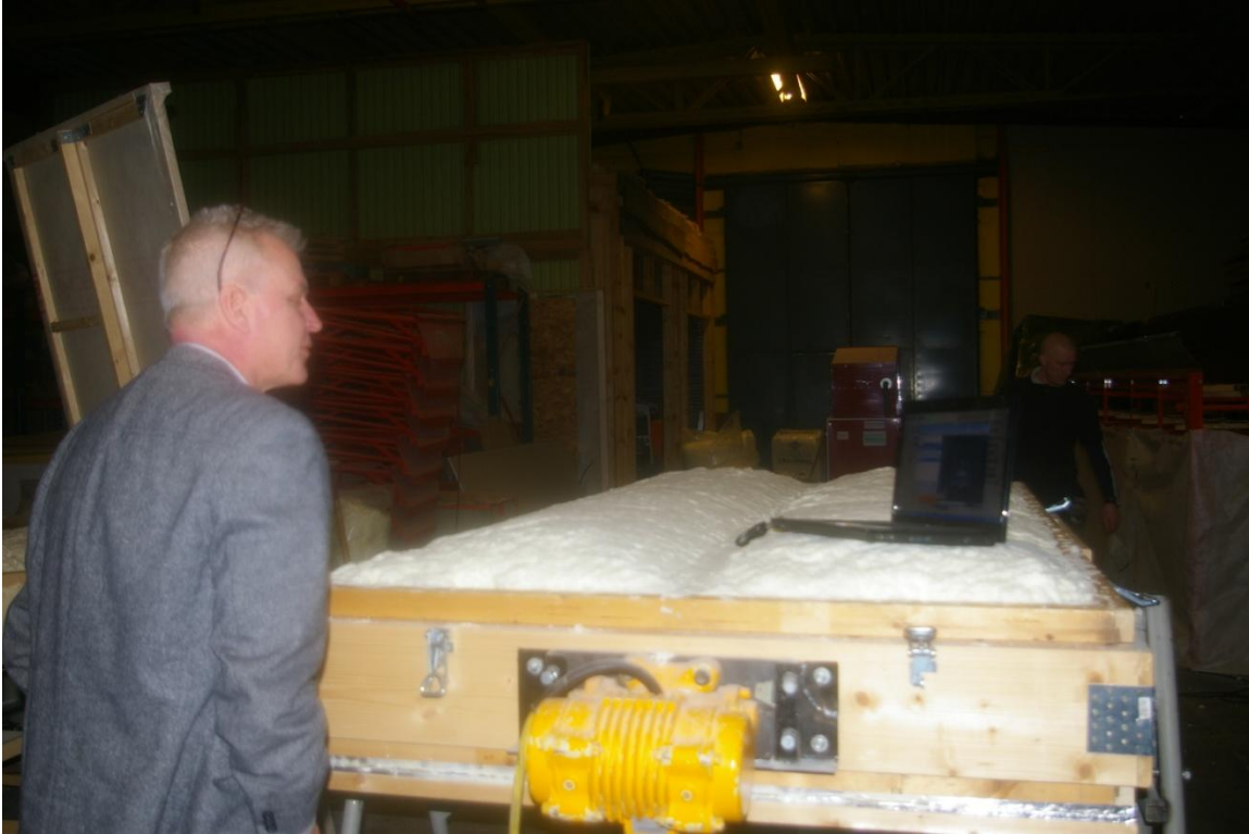
Figur 8. Väggelement sprutat med träfiber.
