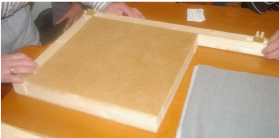
Figur 1. Yttre golvbalkar, syll, pelarfästen och golvblock på plats
