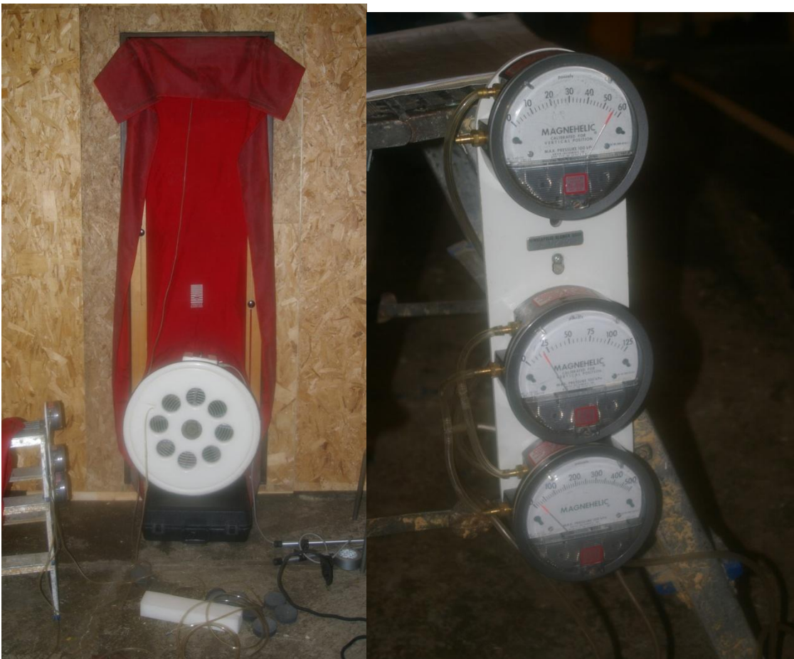
Figur Blower door monterad i dörröppning i det täta utrymmet.
