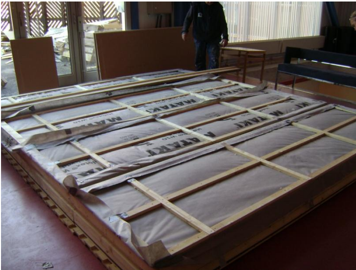
Figur Tätning mellan väggblock med hjälp av fogsium och träfiberisoleringsremsa
