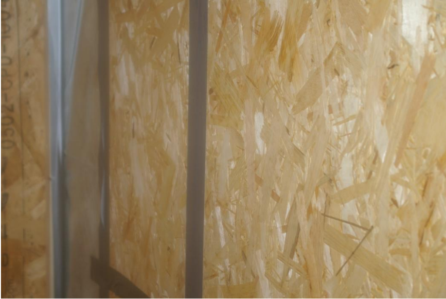
Figur. Övertryck skapades med Blower door i tätt utrymme på väggelementets insida
