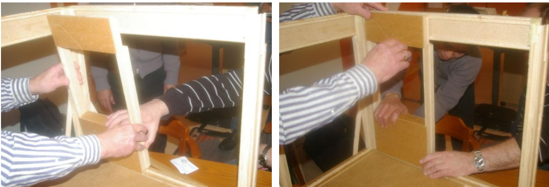
Figur 4a och b. Väggblock med fönsteröppning monteras
