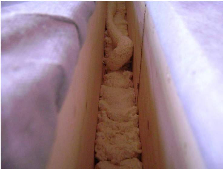
Figur Tätning i skarvar mellan väggblock och mellan väggblock och pelare med skum.
