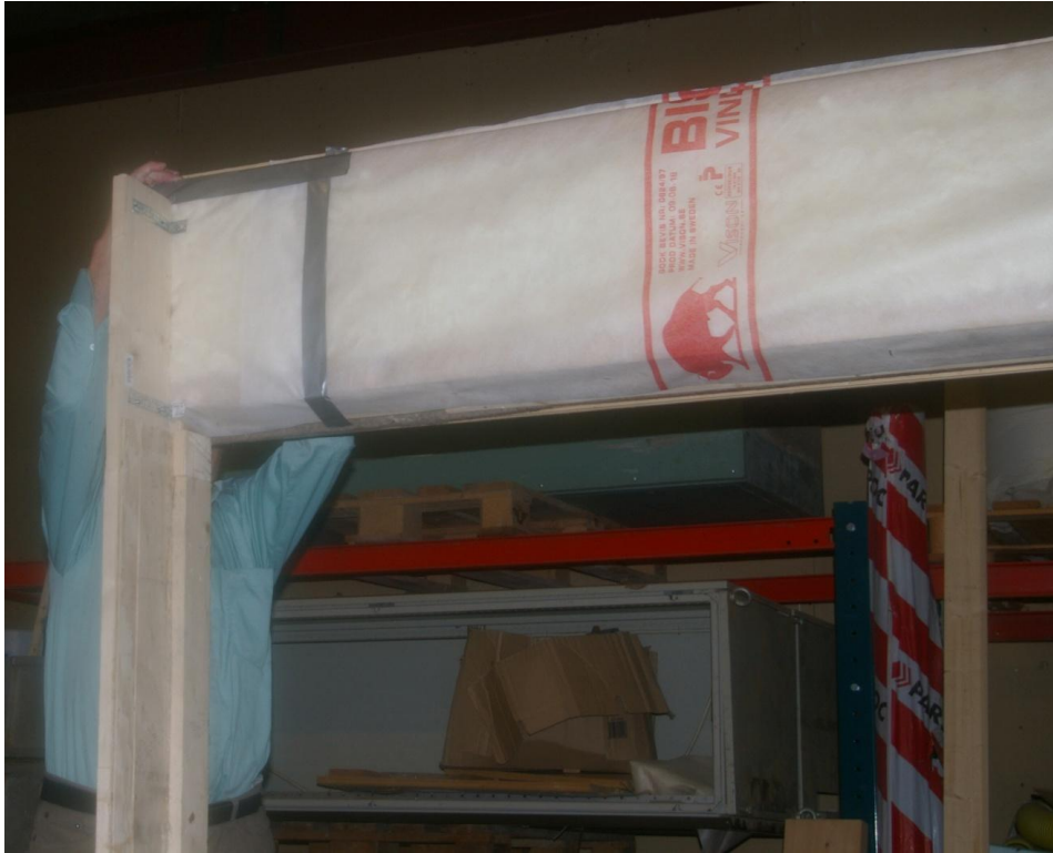
Figur. Montering av huvudbärbalk
