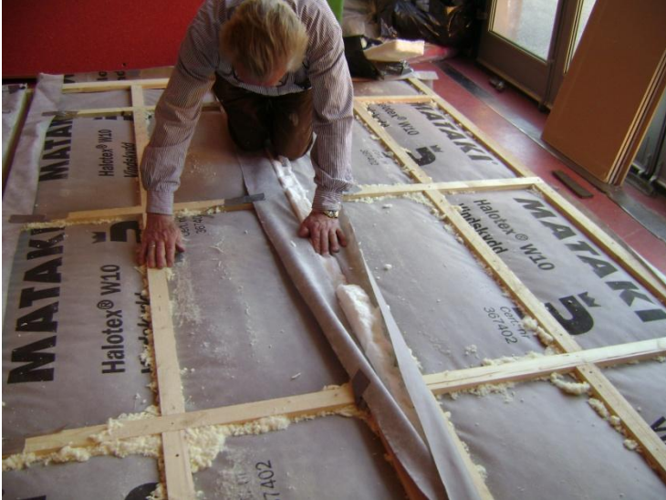
Figur Tätning mellan väggblock med hjälp av fogsium och träfiberisoleringsremsa
