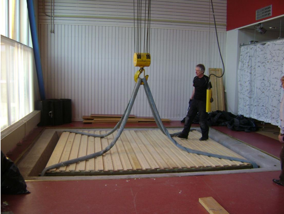
Figur B3. 1 Väggelement har placerats i hålet i bjälklaget
